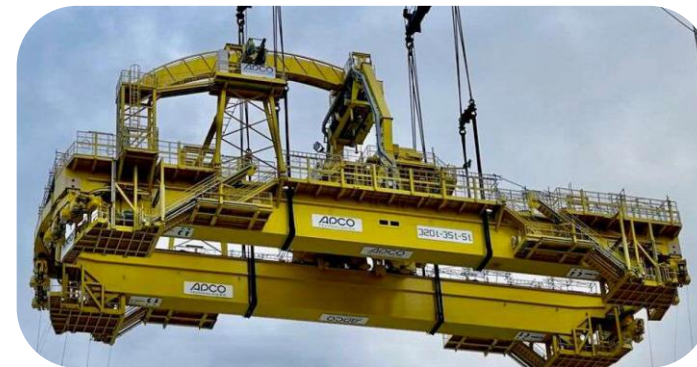
FIRMUS: dostarczenie i montaż podzespołów do dwóch obrotowych dźwigów reaktora EPR Hinkley Point C (UK)
