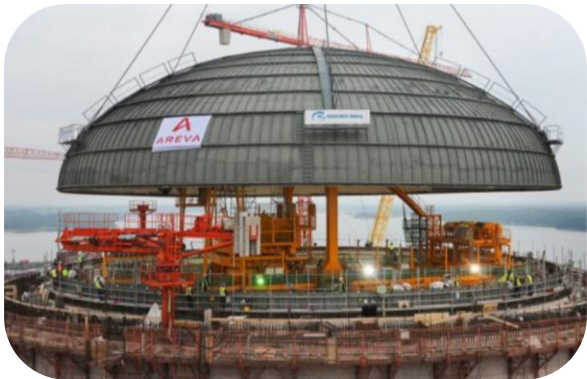
EPG: Wykonanie i dostawa obudowy bezpieczeństwa dla OL3 Finland (FI)
