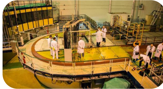
Powen Wafapomp: montaż pomp wody chłodzącej dla obiegu pierwotnego reaktora jądrowego badawczego o mocy 30 MW w NCBJ - Świerk, Poland
