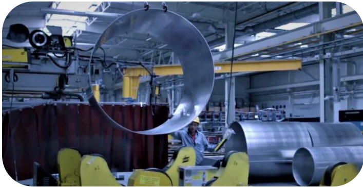
ELEKTROBUDOWA: montaż instalacji elektrycznych Olkiluoto 3 Finland (FI)
